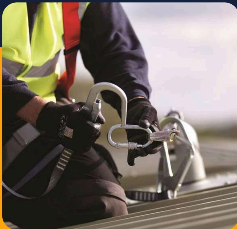
Instalación de líneas de vida horizontal fijas, sobre cubierta y bajo cubierta.
